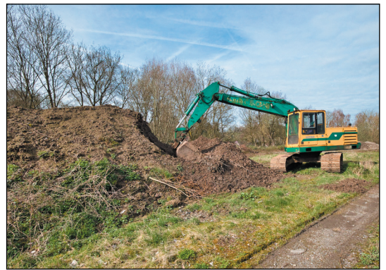
Hier wurde viele Jahre mit dem Bagger der Boden eben gemacht. Zulässig ist eine Reliefveränderung von 0,50 Meter.
